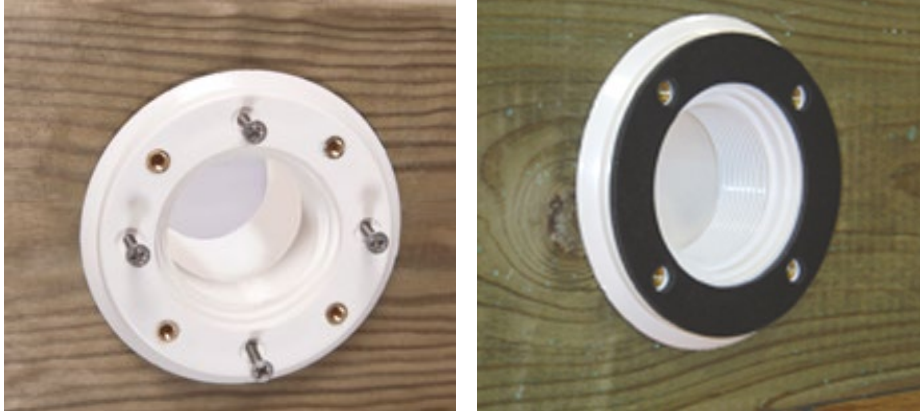
Figuur 23 – Montage van inspuiter en -afdichting
