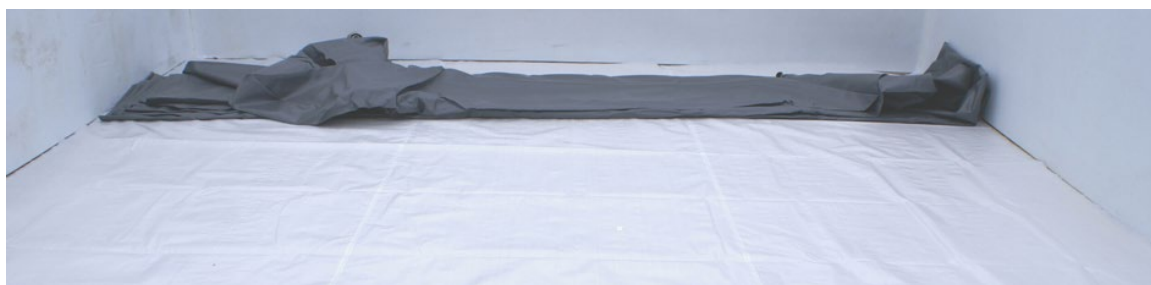
Figuur 32 – De liner uitvouwen
